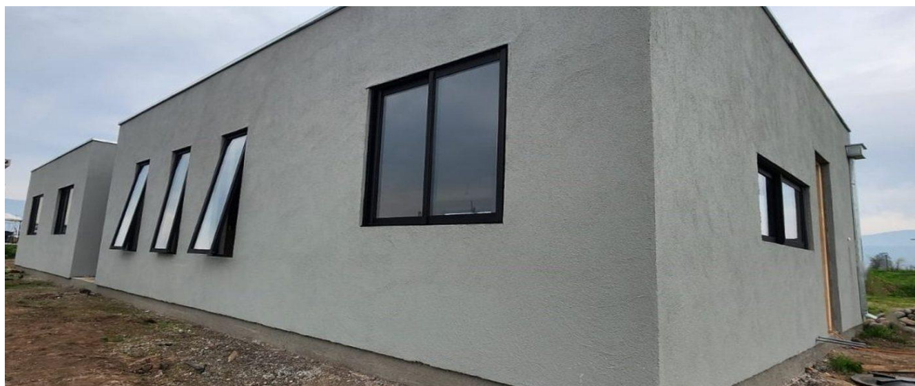
Casa terminada · María Pinto, Melipilla
